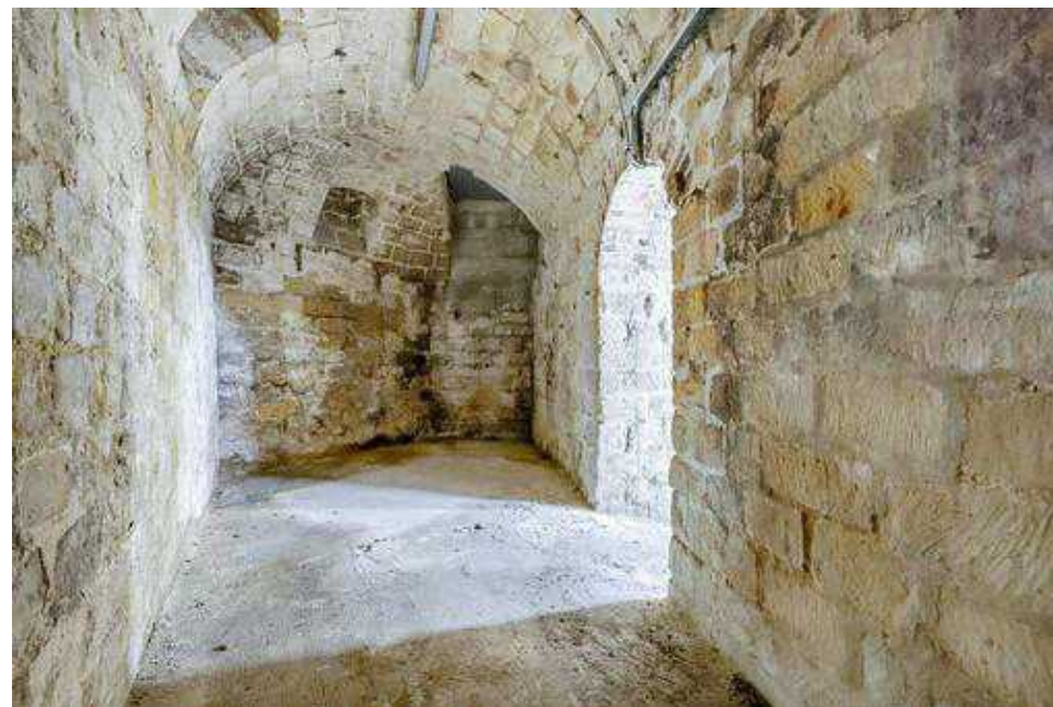
Sous-sol 50 m 2 - Vue lot copro n° 1
