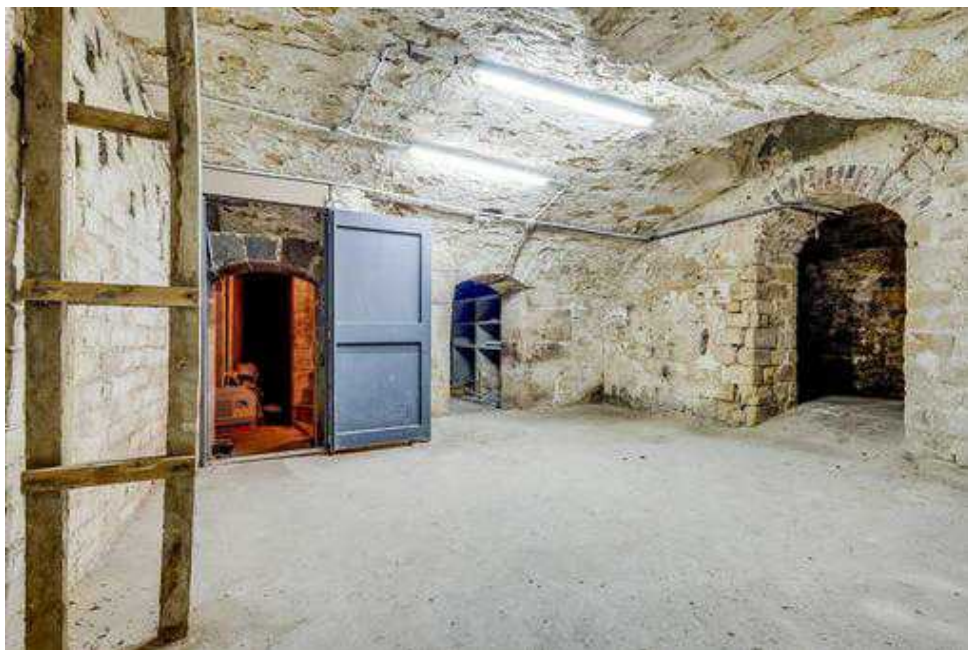
Sous-sol 50 m 2 - #2vue lot copro n° 27 + ouverture trémie plafond
